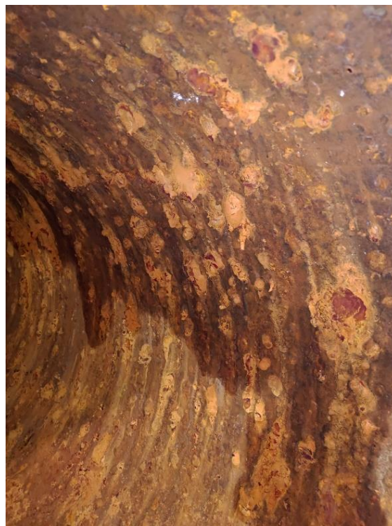
Obr. 2 Začátek potrubí v AŠ (znatelné poškození v podobě inkrustace potrubí)
